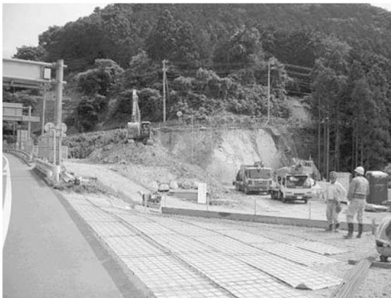
修善寺側トンネル掘削作業
