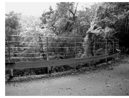
▲達磨山広域林道沿いの不法投棄撤去の後、ガードレールに不法投棄防止柵を設置。不要になった廃材を利用して作成しました。
