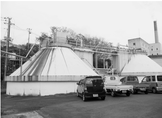
▲清掃センターし尿処理施設
