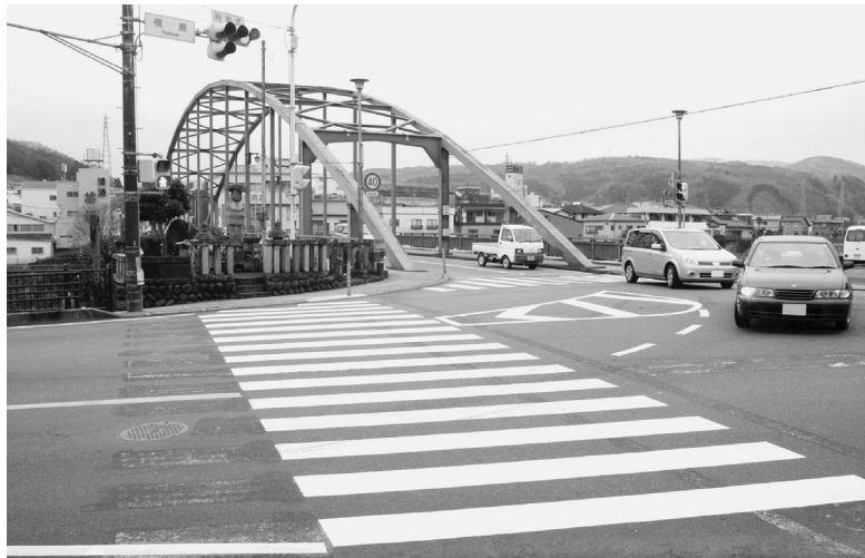
▲押しボタン式の歩車分離式信号へ改良される横瀬交差点の横断歩道
