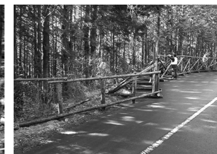
▲大沢区の好意でいただいた間伐材で防護柵設置
