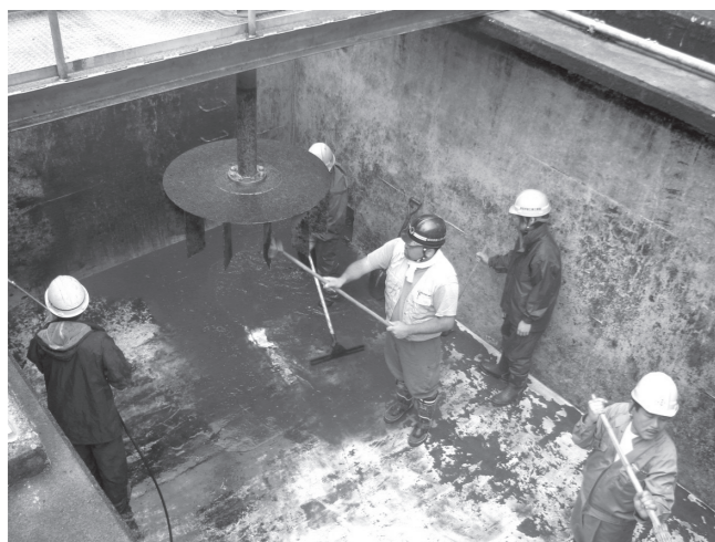
▲浄水場清掃…水槽の泥を取り除き、きれいに磨きました
