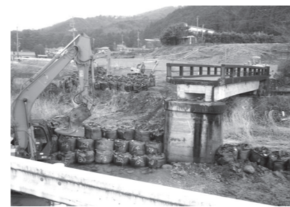
▲押切橋(中伊豆・原保)の架け替え工事の様子
