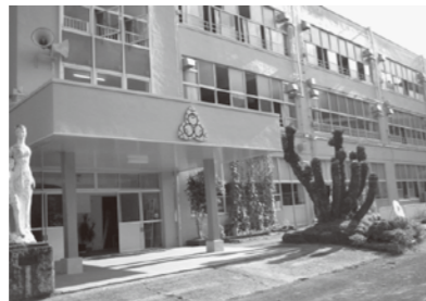
▲きれいなピワ色に塗り替えられた外壁
