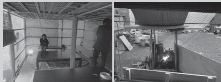
建築足場やブルーシートなどの建築資材で作った自主避難施設(能登町)
