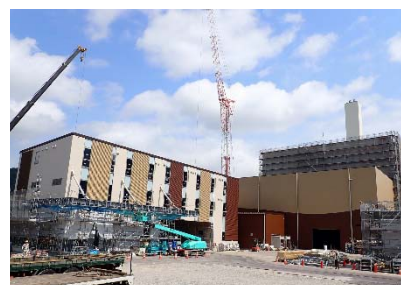
▲建設中の『クリーンセンターいず』
