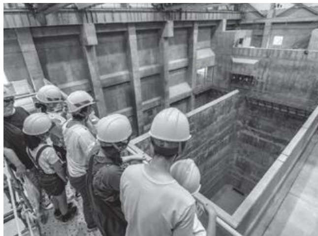
▲火入前の焼却炉をのぞく参加者
