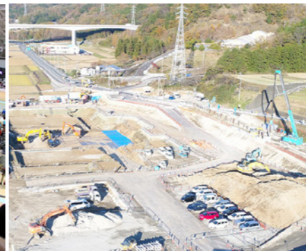
▲建設が進む新ごみ焼却施設
