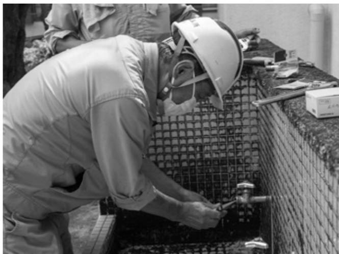
▲外流の水栓コマの取替作業
