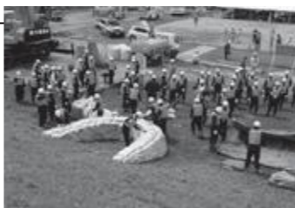
▲消防団員による積み土のうの様子
