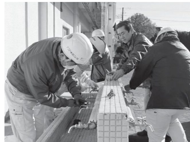
▲グラウンドの水栓を修繕する市営水道相談センター職員
