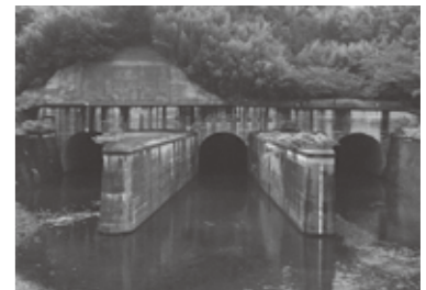
▲狩野川放水路の3つのトンネル
