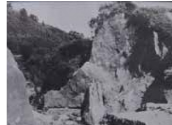
▲崩壊がおさまった蛇喰山
