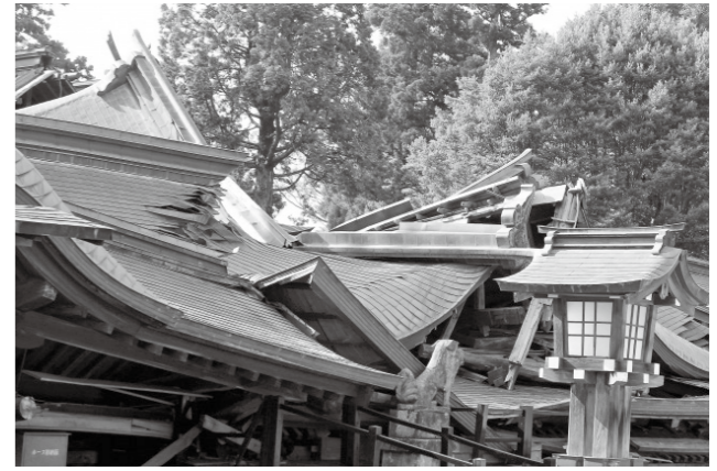
▲熊本地震で倒壊した阿蘇神社
