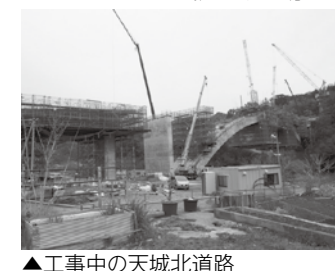
▲工事中の天城北道路
