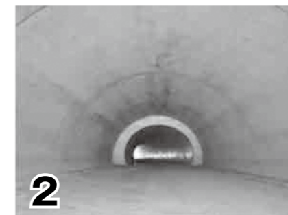
2 下船原トンネルは平成29年3月に貫通。内部はほぼ完成
