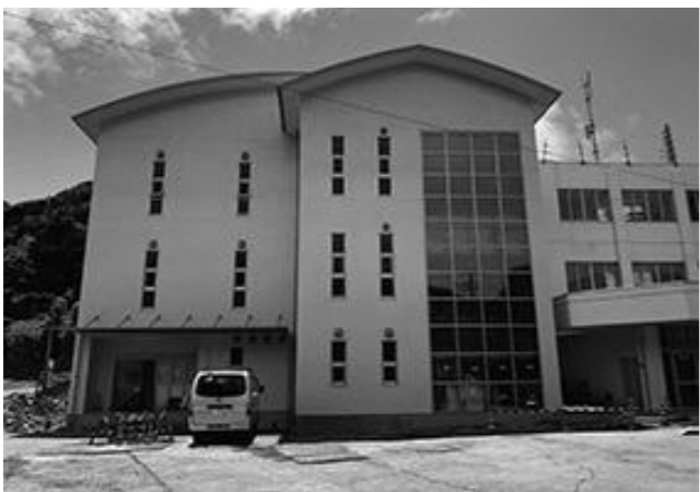
▶4月に開校する土肥小中一貫校の新築部分
