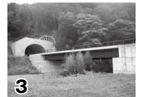
3 下船原トンネルと下船原地区をつなぐ橋りょうも完成。
