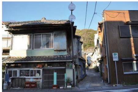
写真 狭隘な道路（避難路）
