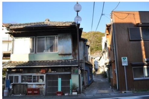
写真 狭隘な道路（避難路）
