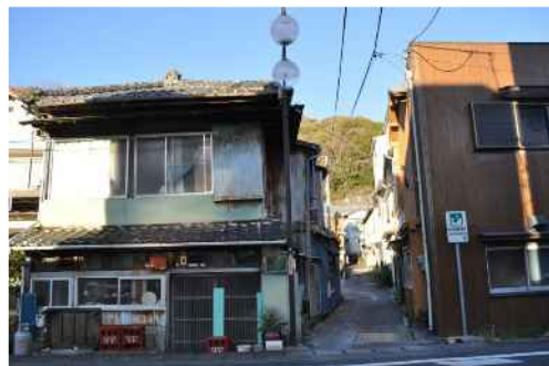
写真 狭隘な道路（避難路）
