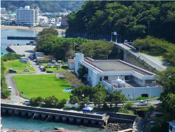
特定環境保全公共下水道 土肥浄化センター
