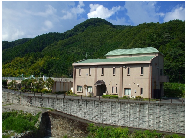
特定環境保全公共下水道 湯ヶ島クリーンセンター
