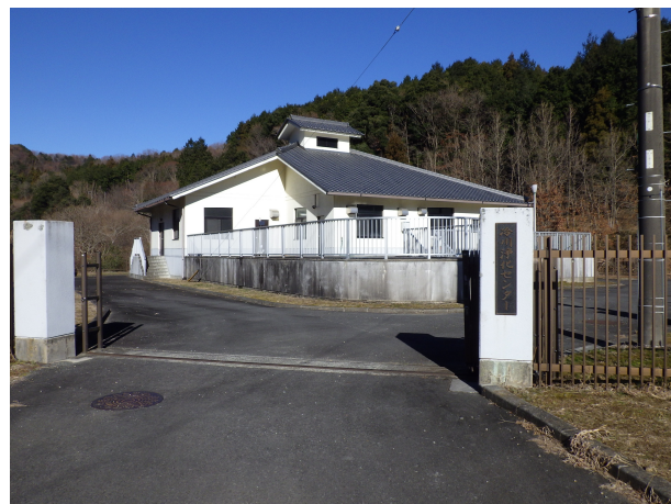
農業集落排水 冷川処理場
