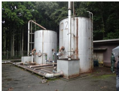
雲金浄水場(天城湯ヶ島)
