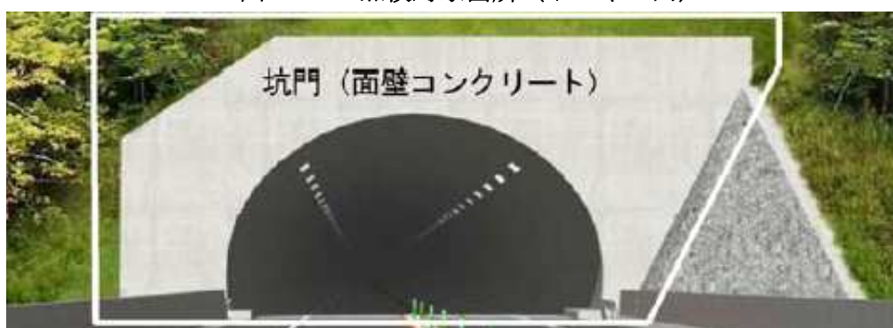
図-4.3 点検対象箇所（トンネル坑口部）
