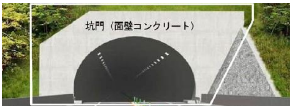
図－4.3 点検対象箇所（トンネル坑口部）
