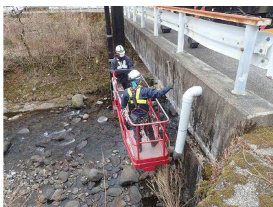
写真. 5 橋梁点検車での点検 (金沢橋 湯ヶ島地内)
