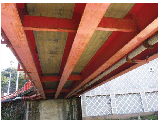
写真. 1 鋼橋 (渡月橋 修善寺地内)
