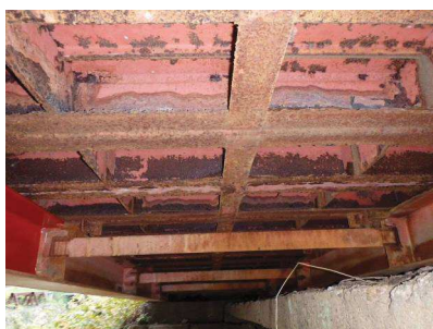
写真. 7 塗装塗替え補修前 (大堰橋 梅木地内)
