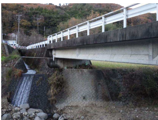
写真. 2 PC 橋 (鈴原橋 大平柿木地内)
