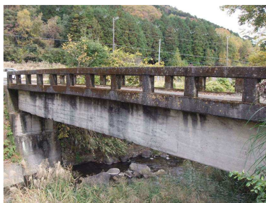
写真. 3 RC 橋 (松振橋 大沢地内)
