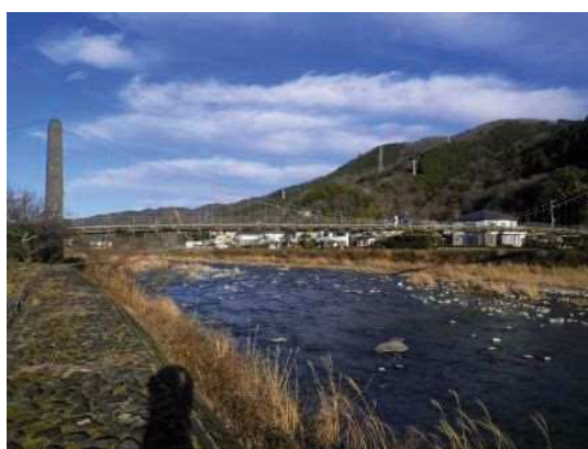
写真. 4 その他の橋 (吊橋) (松ヶ瀬橋 松ヶ瀬地内)
