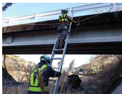
写真. 6 はしごでの点検 (芳原橋 修善寺地内)
