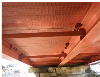
写真. 8 塗装塗替え補修後
