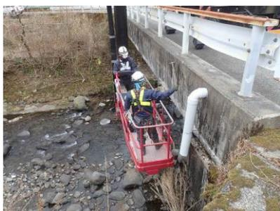
写真. 5 橋梁点検車での点検
