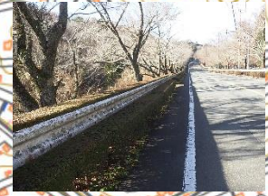
歩道のない遊歩道
