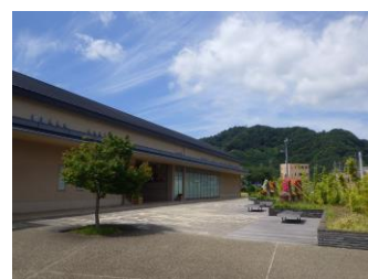
修善寺駅駅舎
