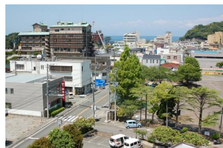
土肥支所周辺 (土肥地域)
