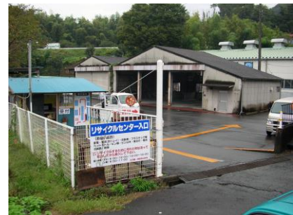
伊豆市清掃センターリサイクル施設
