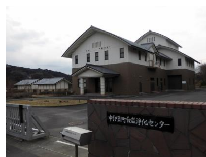
下水道処理施設（白岩浄化センター）
