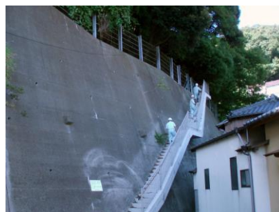
急傾斜地崩壊対策事業
