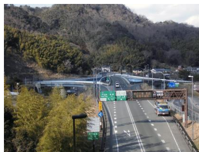
広域幹線道路（修善寺道路）
