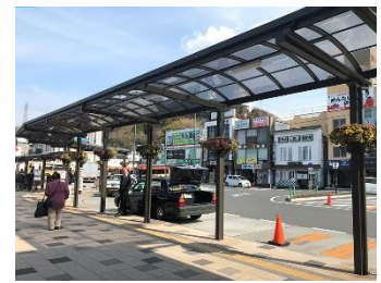
修善寺駅南口駅前広場
