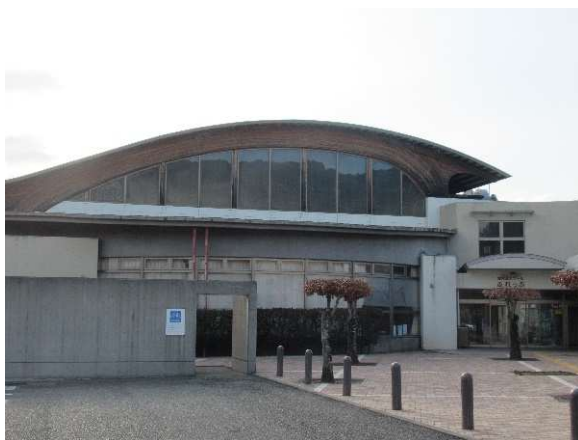
▲長寿命化工事を行う中伊豆室内温水プール「ふれっぷ」
