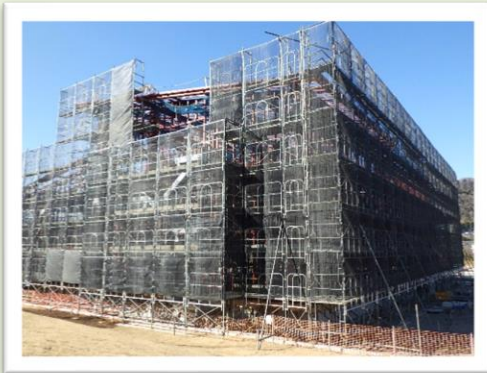
▲建設中の「危機管理センター」
