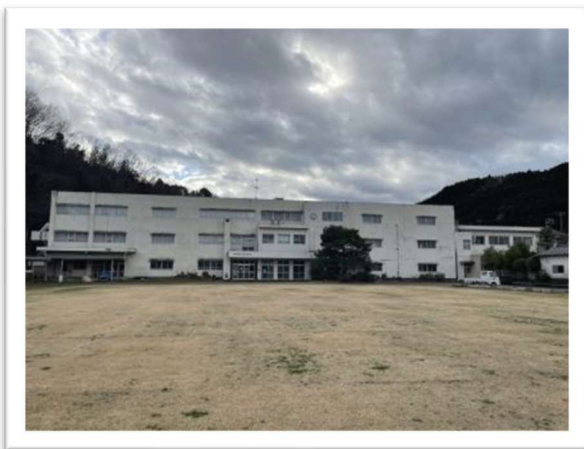
▲解体改修工事を実施する旧八岳小学校
