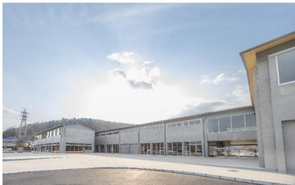
▲完成した伊豆中学校
