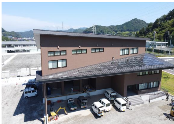
▲建設中の危機管理センター
