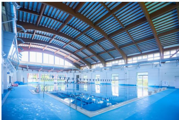
▲工事が完了した中伊豆室内温水プール「ふれっぷ」
