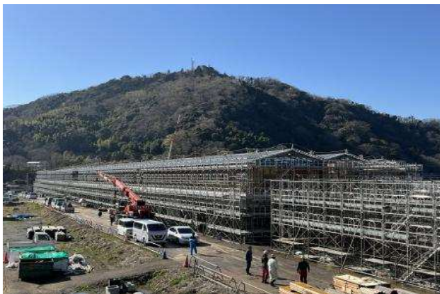
▲令和7年度開校において建設を進める新中学校
