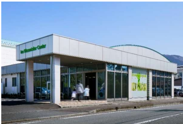
▲完成した Izu Wasavisitor Center
