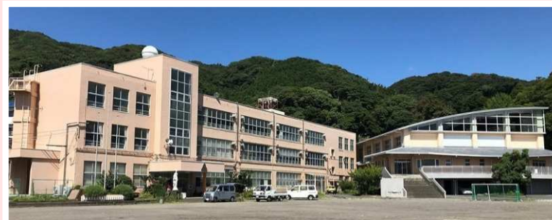
地域拠点として活用する旧土肥小学校
