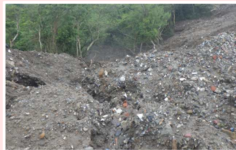
平和寺本山から流出した土砂廃棄物
