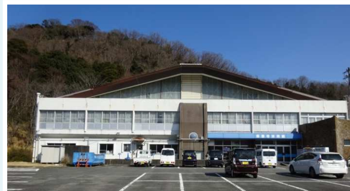
解体を予定する修善寺体育館
