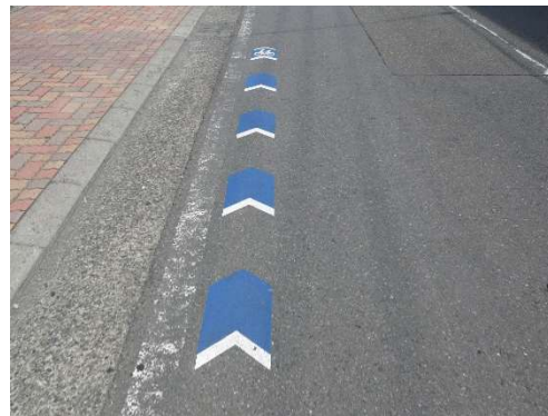
写真 狭い区間での矢羽根型路面表示（静岡県）
