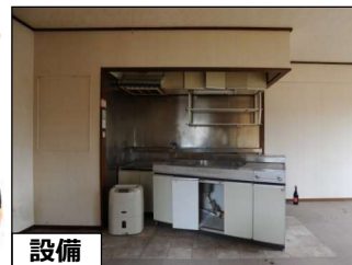
柱、内壁、床、天井
