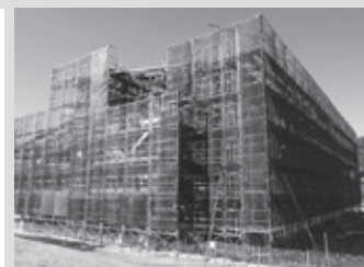
▲建設中の危機管理センター
