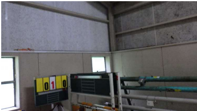
⑦ステージ横倉庫
