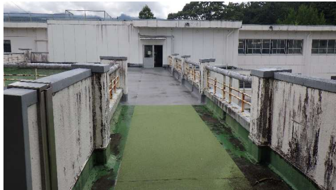
②東側渡り廊下屋上
