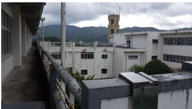
⑤西側渡り廊下より中庭方面
