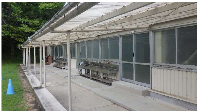
⑨技術棟入口
