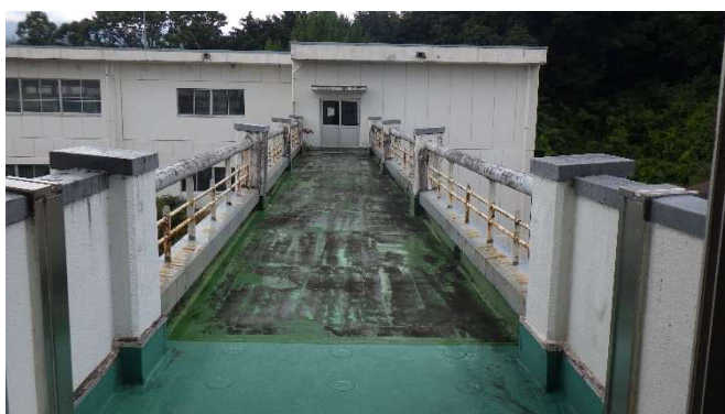
⑥西側渡り廊下屋上
