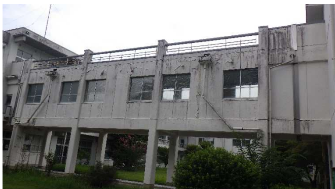
⑰西側渡り廊下
