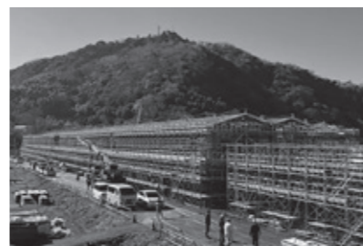
▲令和7年度開校に向け建設中の伊豆中学校
