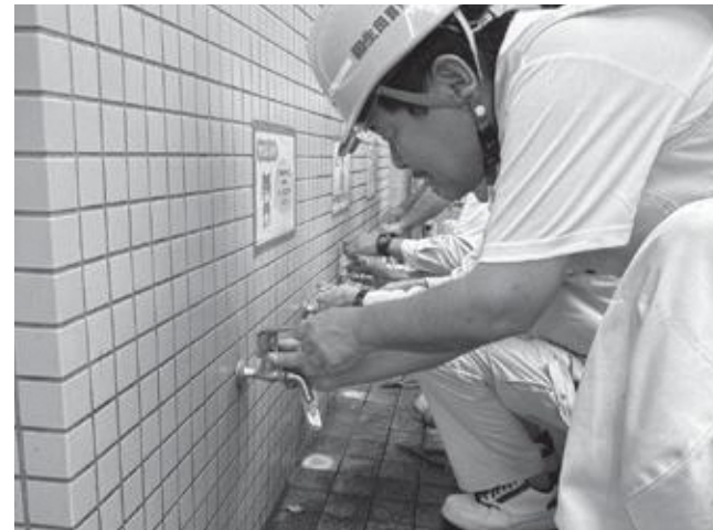
▲水道の部品を交換するボランティアスタッフ
