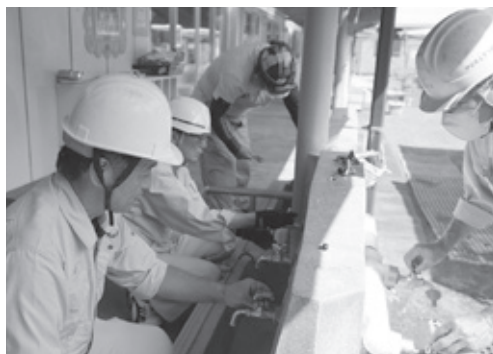
▲水道設備点検の様子
