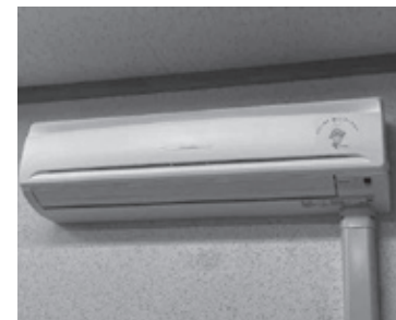
▲整備されたエアコン
